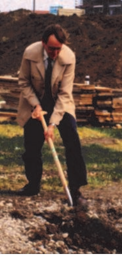
Kurat Hans Krämmer beim symbolischen „Ersten Spatenstich“
